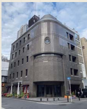
アールと角がうまく調和された建築(今回のイケフェスで発見した建築)
