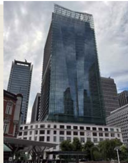
JPタワーの全景(左:大阪、右:東京)
