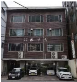
写真2：角の丸い窓が使用された戦後ビル
