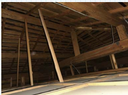
新居の天井裏の様子
