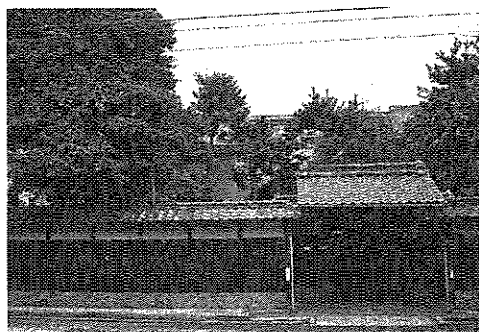
自主的な保存活用を行う加藤邸（自習舎）
