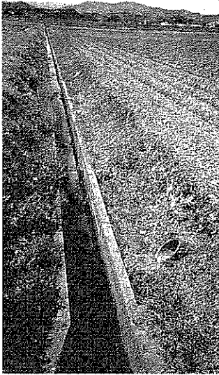
図3：コンクリート製農業用水路とほ場整備済み水田からの排水口（右側）。排水口と排水路水面とが大きく乖離。魚が産卵のためさかのぼるのは無理。豊岡市内で。
