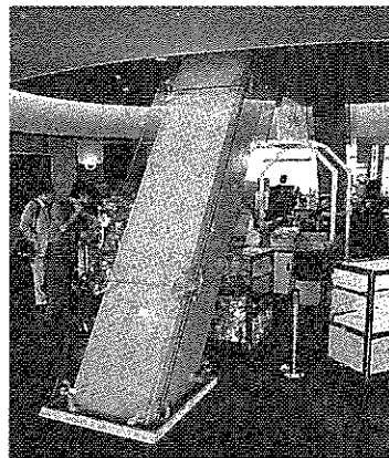
ガラスで覆われた主要構造部の鉄骨
