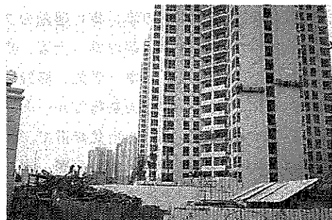
写真2：ここはシンガポール？高層マンションの建設ラッシュ！(ジャカルタ)
