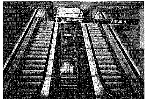
オーフツ市中央駅：コンコースからホームへのエレベーター、階段、エスカレーターが一体となっている(日本では見られない)
