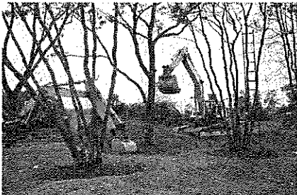
写真4：位置を修整しながら埋戻す (写真提供：石勝エクステリア)
