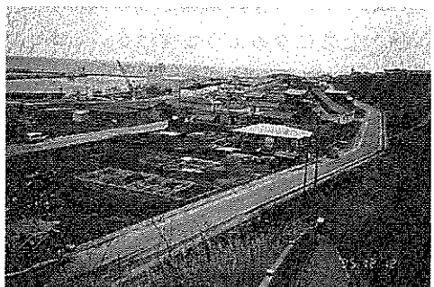
防潮堤の設置と盛土工事をを行い道路設置等の基礎整備は概ね終了
