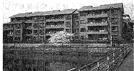
周田の景観を考慮した京都府営住宅「西天王町団地」
