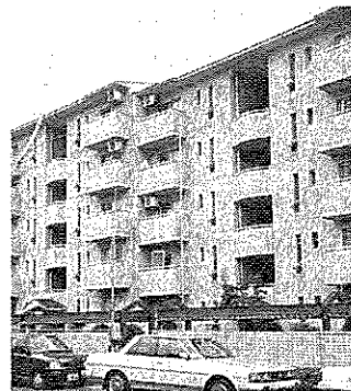
震災で周辺の共同住宅が倒壊する中、無傷の公営住宅（神戸市）
