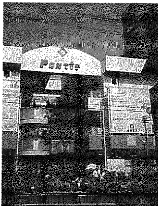
「ポンテリカ山科」正面 右側は建設中のD棟
