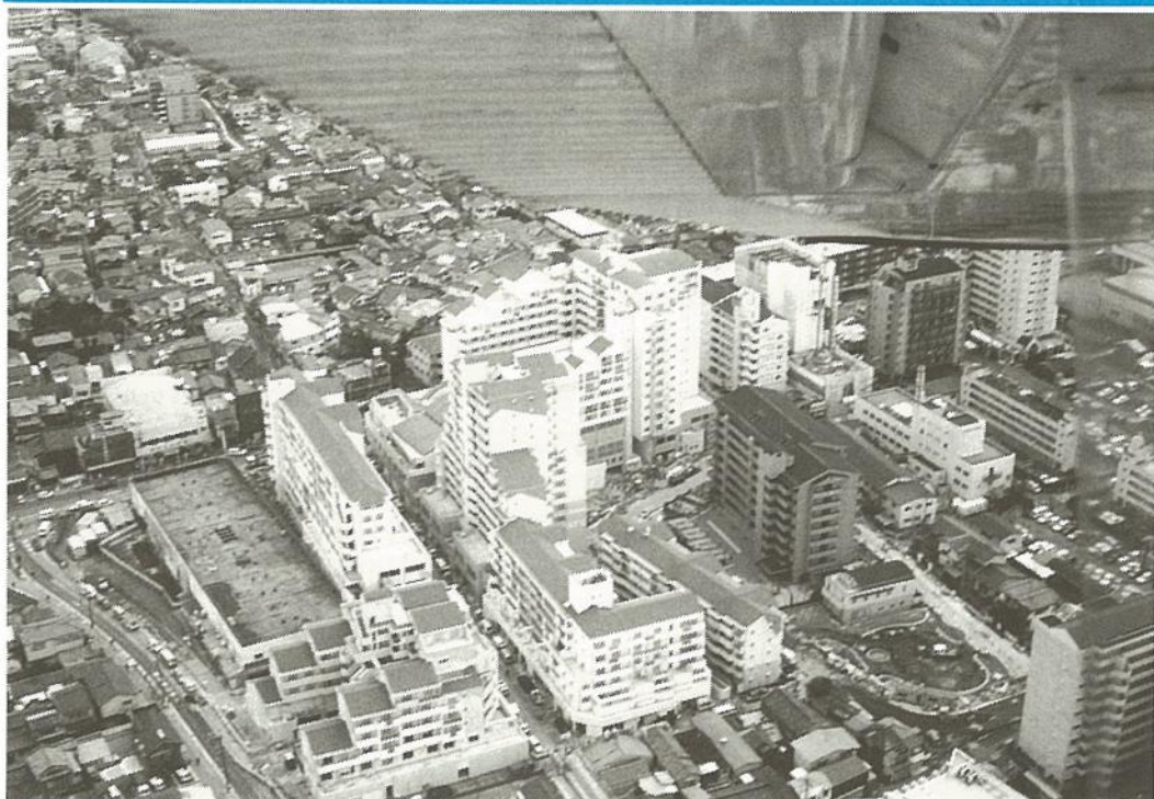
「アミンガ潮江イースト(JR尼崎駅北第一地区第一種市街地再開発事業)」が竣工しました (本文中に関連記事があります)
