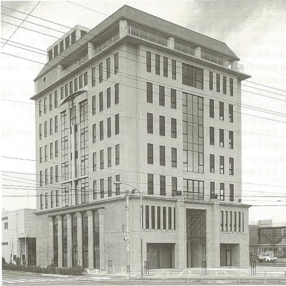
京都ファッション産業団地「メモワールビル」が竣工しました (本文中に関連記事があります)
