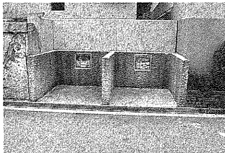
三田ニュータウン (兵庫県) 宅地切込型でスペース創出、ごみ種別で区分している
