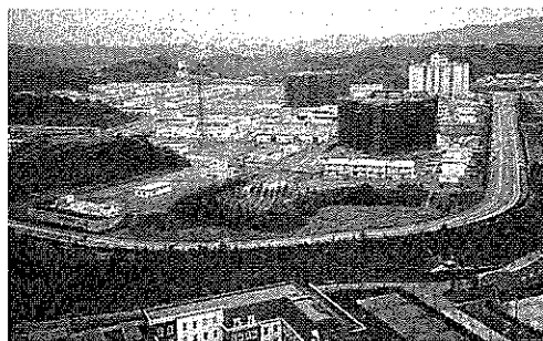
リゾートマンション建設中：新聞には「進む社用リゾート化」と書かれている。
