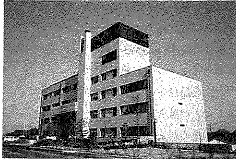
川島町民会館
