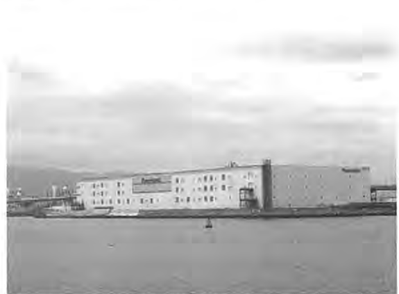
松下 PDP 国内第 3 工場(隣接地に第 4 工場を建設中、第 5 工場も計画)
