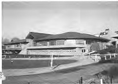
センターハウスの南西面外観
