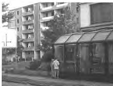
写真2：解体を待つ住宅
