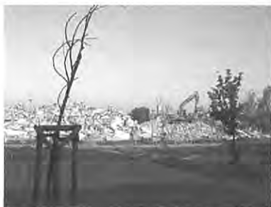
写真1：集合住宅を解体中
