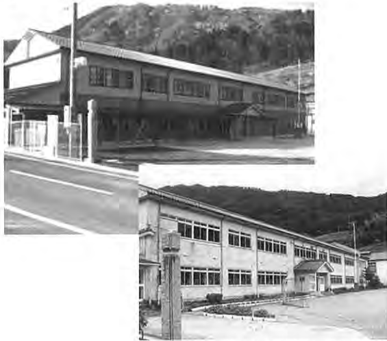
写真上：改築後 下：改築前
