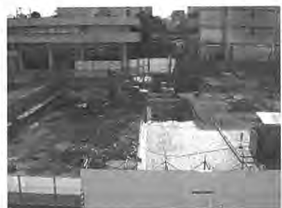
解体中の千里中央地区センタービル
