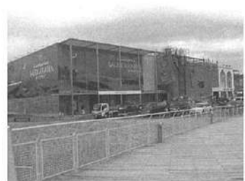
工事中のサウジアラビア館
