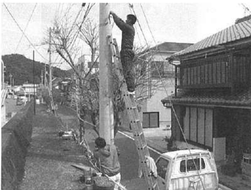
東由岐自主防災会では過去の津波高さを示すテープを設置しています。 (上が安政南海地震、下が昭和南海地震の高さ)
