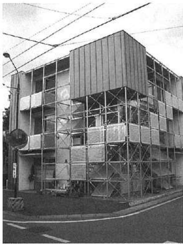
ふるさと福祉村・西濃事務局のある建物（池田町） ふるさと福祉村・西濃の活動テーマの一つ「環境」を意識した建物です。解体・移築が容易で廃棄物とならない、使う人が自由に使い方を工夫できる、人と環境にやさしい建物です。
