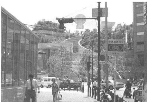
段丘状にそびえる屋上公園 一階には関西では最大規模のウイメンズ難波がある
