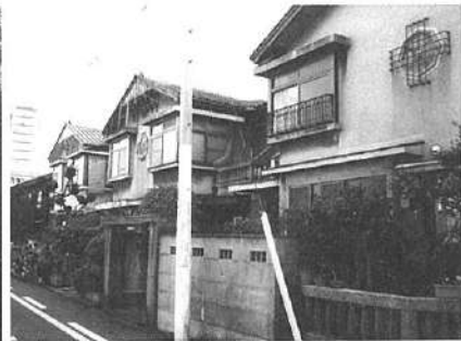
辻榮住宅経営部洋風長屋：大阪住之江区西住之江
