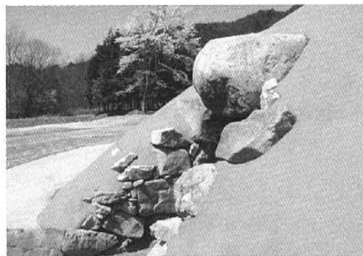
透水性樹脂舗装による墳丘の復元
