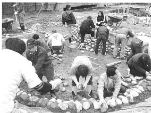
池づくり：護岸石積み作業
