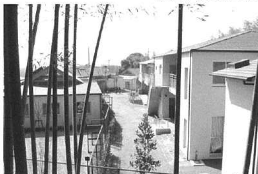
街道にみたく敷地内の道路
