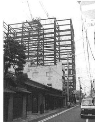
町屋に覆い被さる御池通のマンション現場
