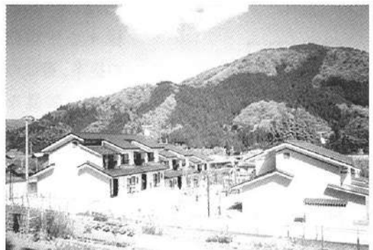
東下りの斜面地に2棟を南面配置しました 土壁風テクスチャーをもつ妻壁
