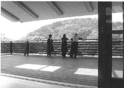
デッキ手摺は木製手摺りの内側にアルミのパンチングを貼っています
