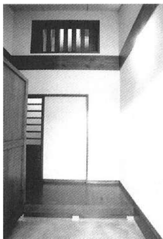
民家風の土間玄関には2階から見下ろす無双窓をうがつ
