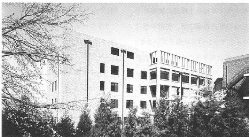
木立の中の清風館
