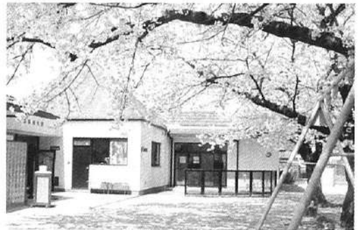
住吉西保育園：尖り屋根の右側手前が増築部
