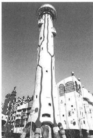
回転展望室つきのタワーに見える煙突。氏の当初のデザイン案では螺旋階段とレストラン等を設けたかったそう。
