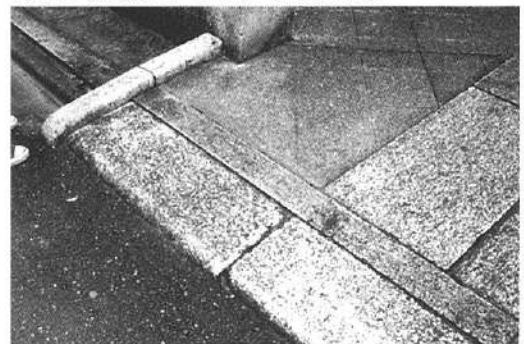
玄関側溝のふた石
