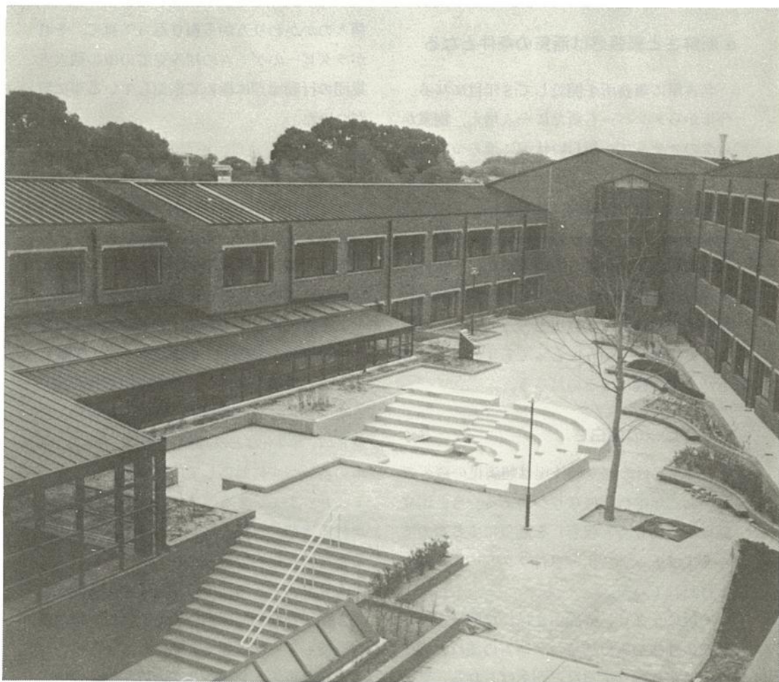
完成まぢか 京都橋女子高等学校移転新築工事 中庭風景
