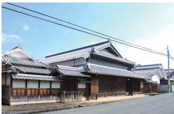
修理例 森田家修理後
