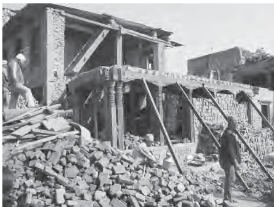
震災がれきの出ない煉瓦の再利用（バクタプル）
