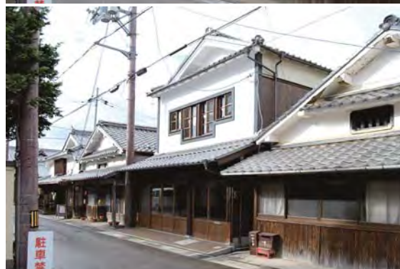
修理例 小林家（上：修理前 下：修理後）
