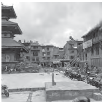
Taumadi 広場の西南の崩れたパゴダを見る 撮影：アルパック OB 倉本恒一
