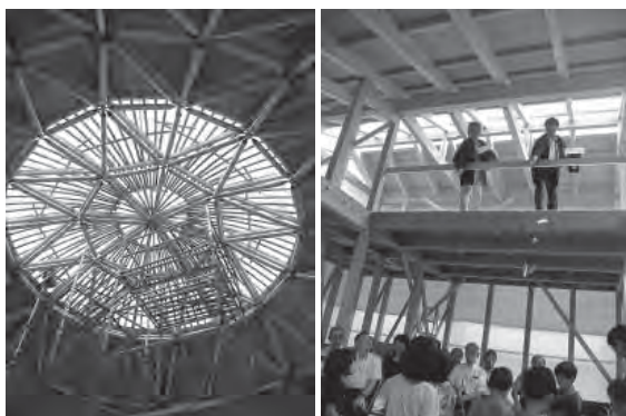
組立中のドーム
