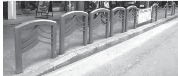
四条通の防護柵
