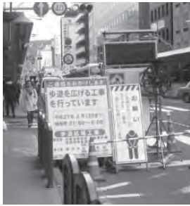
拡幅工事中の四条通
