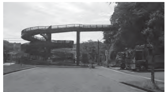
避難ループ橋：白杵城跡
