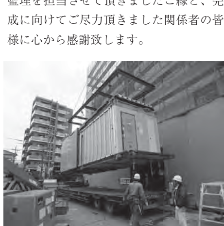
やごと光風観 鉄骨ユニットの建方状況
