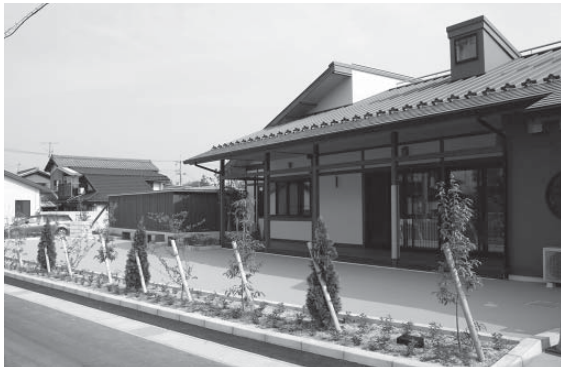
ランチルームテラスと街角広場
