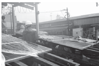
雨降りしきり中での設置作業。施工も担当
