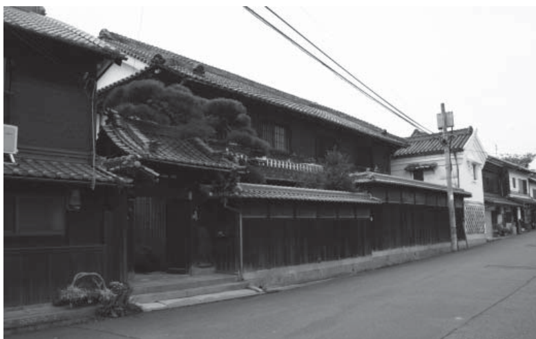
旧水井家住宅 北側外観
