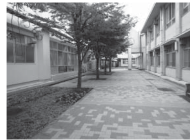
改修された実習棟（左）と中庭
