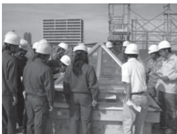
建築インテリア科を対象とした現場見学勉強会
