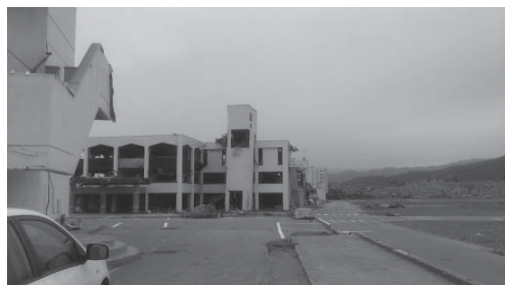
嵩上げを待つ旧市役所より海岸線を望む
