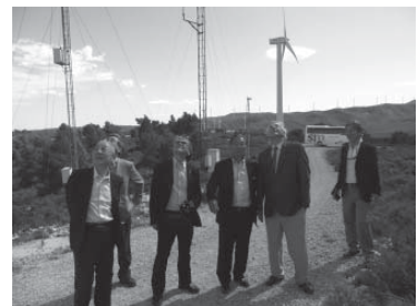
バルセロナ郊外のコラデラス風力発電所
