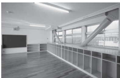
補強の鉄骨ブレース
