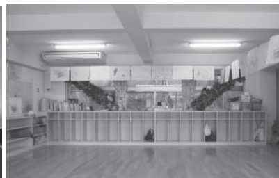
ツタが巻き付けられたブレース
