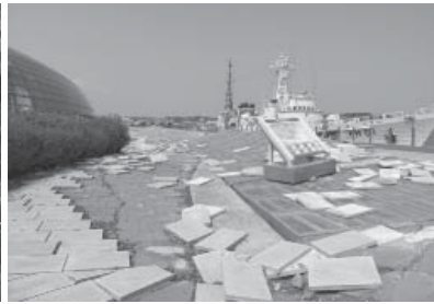
地震と津波の影響を受けた小名浜港親水公園 (福島県いわき市)
