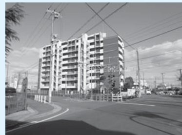
日常の風景の中にある現場マンション
