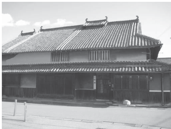
造り酒屋の建物（景観形成重要建造物：中村・粟賀町）
