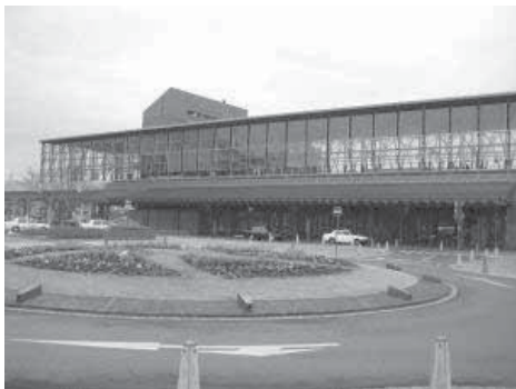
新しく整備された日向駅
