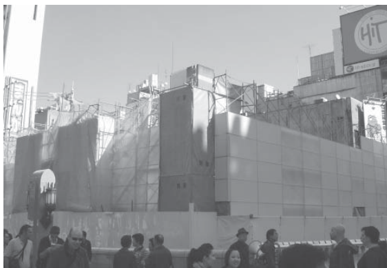
行燈部分が無くなったKPO キリンプラザ大阪
