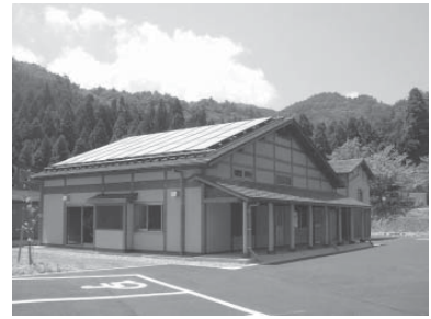
ソーラー給湯用パネル
