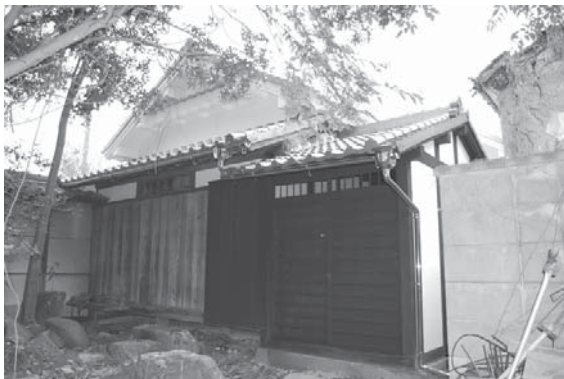
N家修理工事
