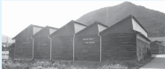
のこぎり屋根の織物工場
