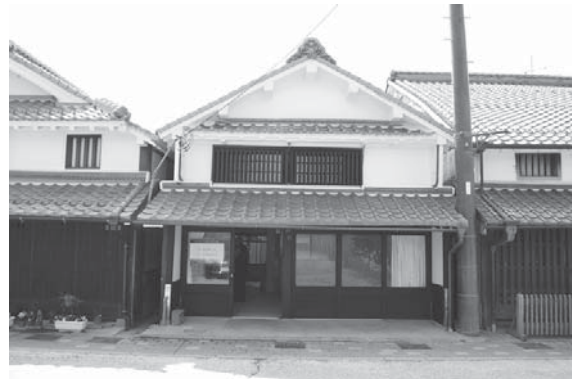
K家修理工事
