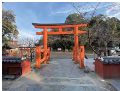
③ 拝殿前の既存鳥居（袖柱の付いた木製鳥居）と既存の青石乱張り舗装
