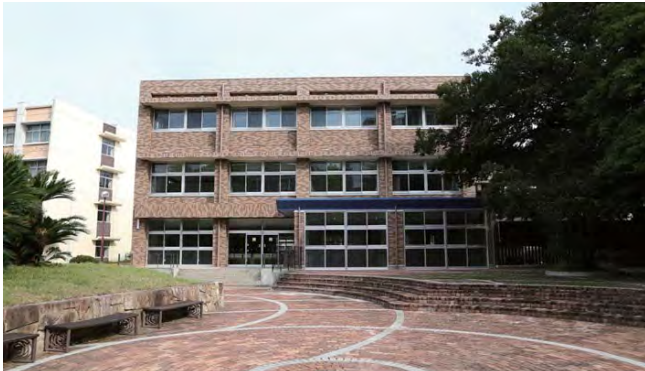
リニューアル後の学生会館南面外観：外壁改修のタイル張りは、外壁材の落 下を防止するピンネット工法を採用
