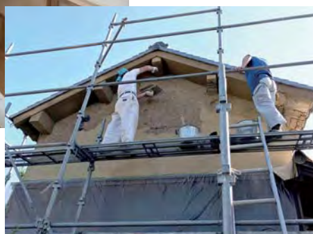
壁と軒裏の修理の様子
